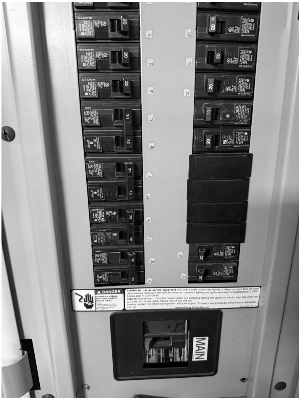
2 EXISTING PANEL 'LV' Scale: N.T.S.
